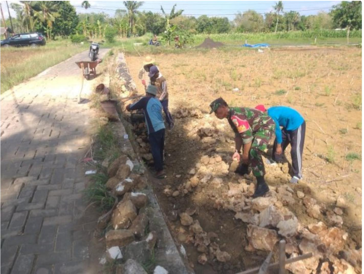
SUMENEP - Kondisi curah hujan yang tinggi menyebabkan ancaman terjadinya banjir, tanah longsor dan erosi tepi jalan di Desa Beluk Ares Kecamatan Ambunten. Oleh sebab itu, perlu adanya perbaikan jalan dengan pembuatan plengsengan atau yang dikenal dengan Tanggul Penahan Tanah (TPT).
